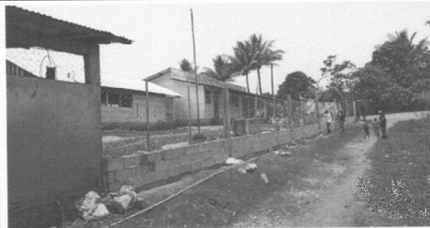
Foto 2: Se observa la colocación de la malla enfrente de la escuela.
