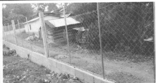
Foto 3: Se observa el uso de los tubos galvanizados para el sostenimiento de las mallas.
